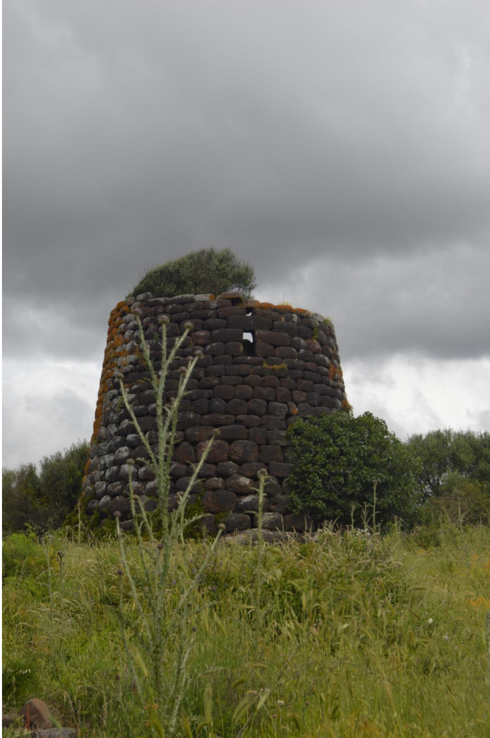
Nuraghe Ponte: prospetto sud
