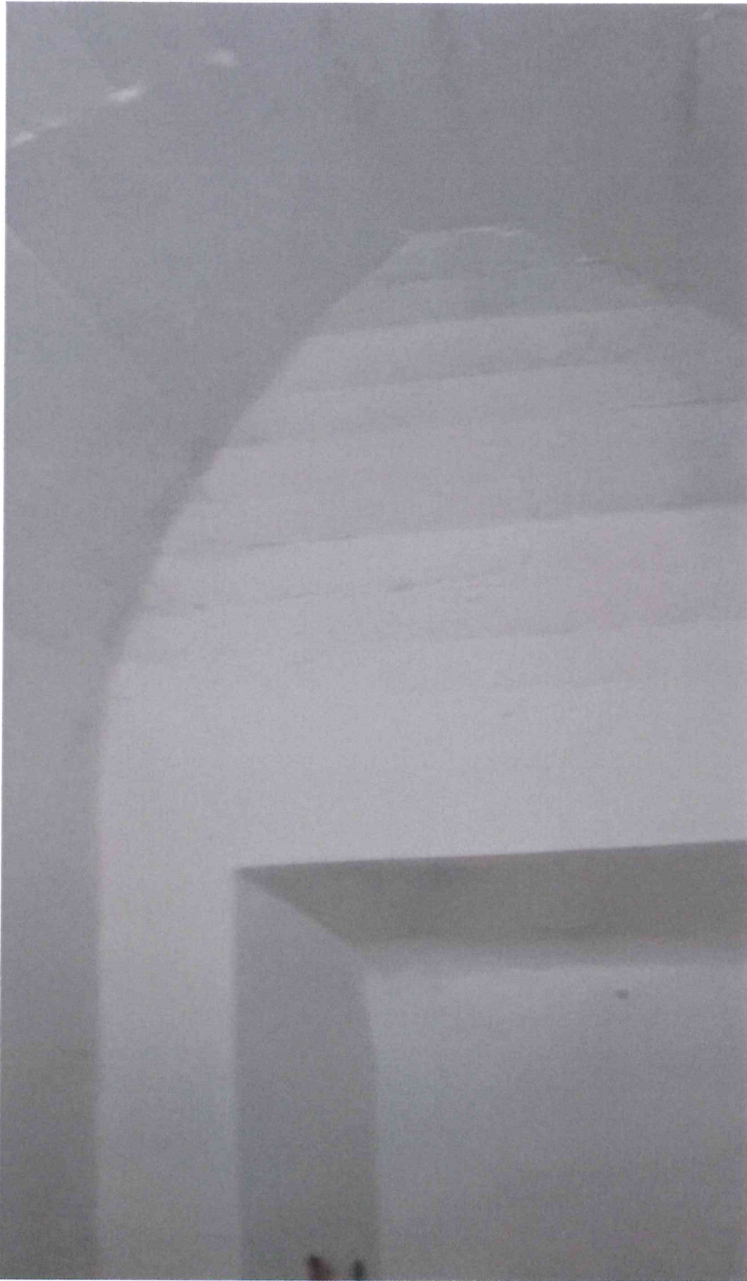
Volta carenata in cemento armato del fortino
