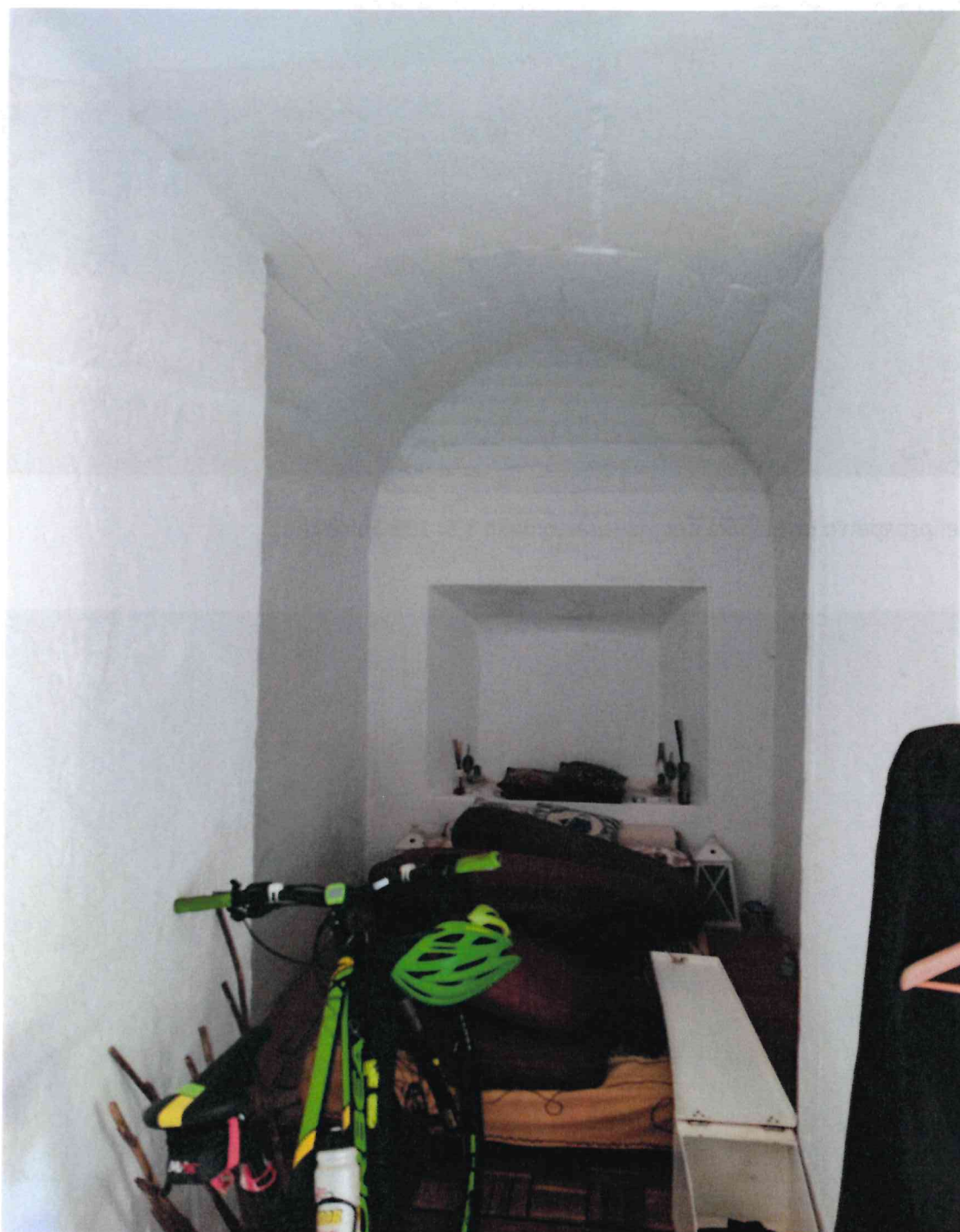
Vista dell'interno del fortino con inquadramento della bocca di fuoco orientata a sud e tamponata in epoca successiva all'uso
