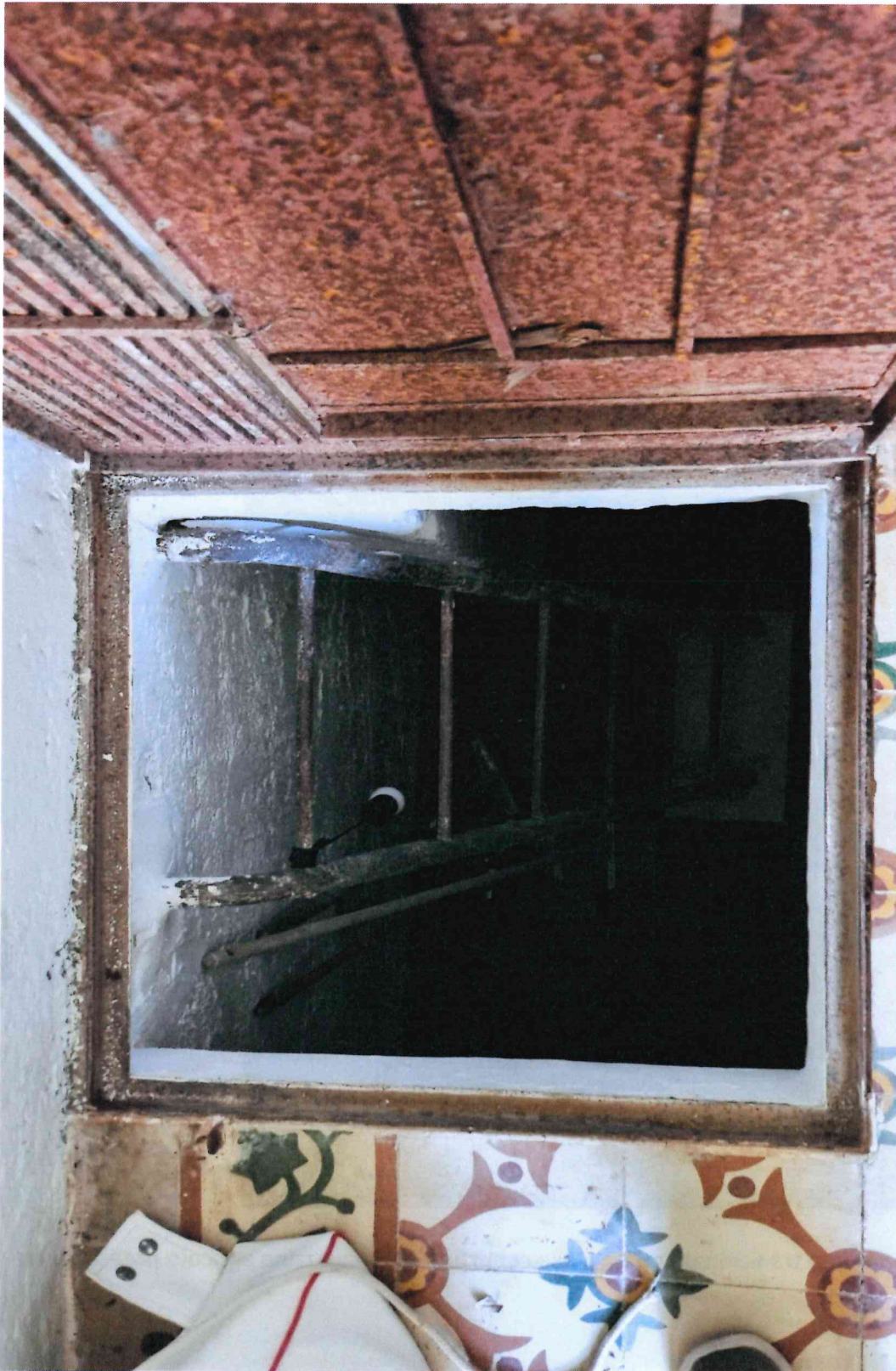
Botola di accesso al vano protetto seminterrato
