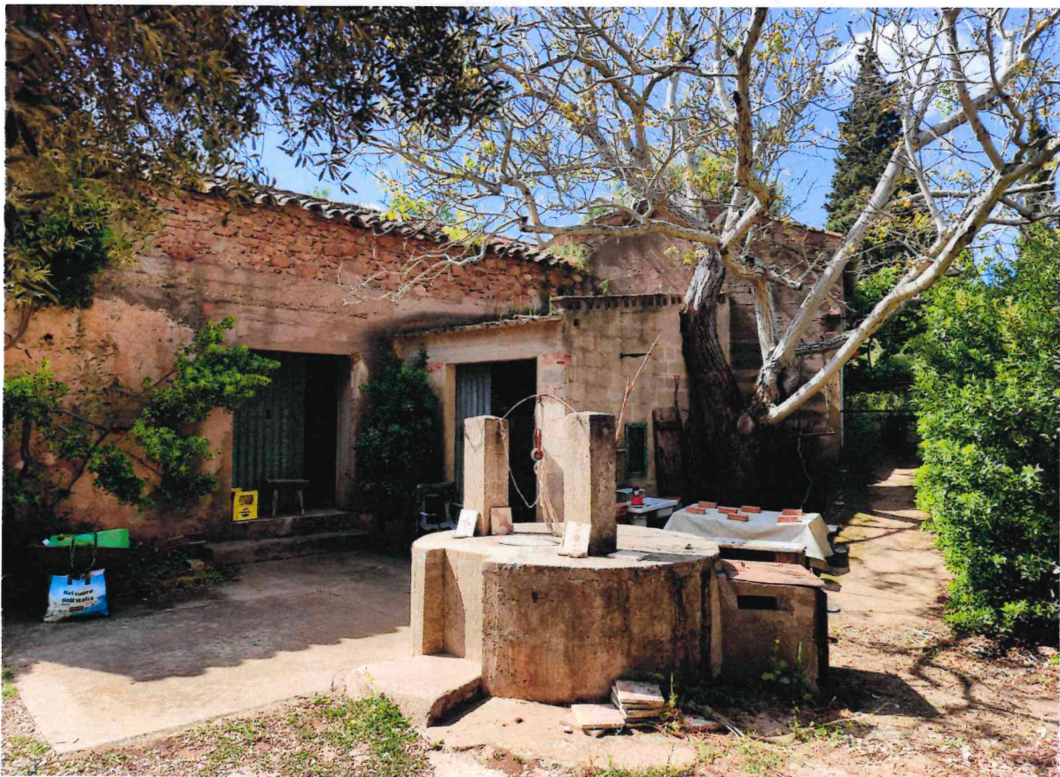
Vista degli ampliamenti di rinforzo in c.a. e del pozzo presi dal cortile sul retro del lotto
