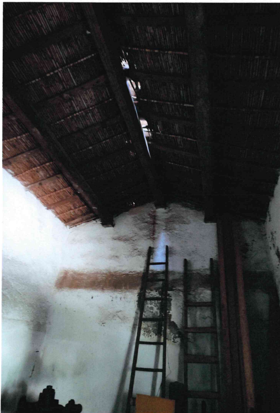
Tetto in incanniccato tradizionale relativo alla copertura del magazzino agricolo preesistente
