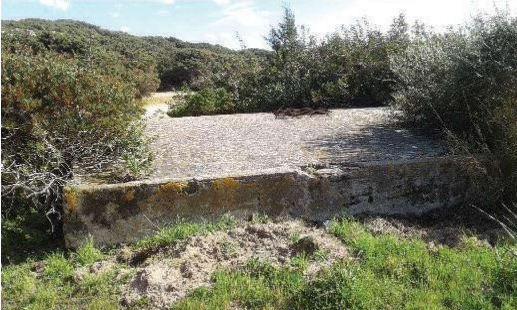
Case Bianche: fabbricato B - cisterna
