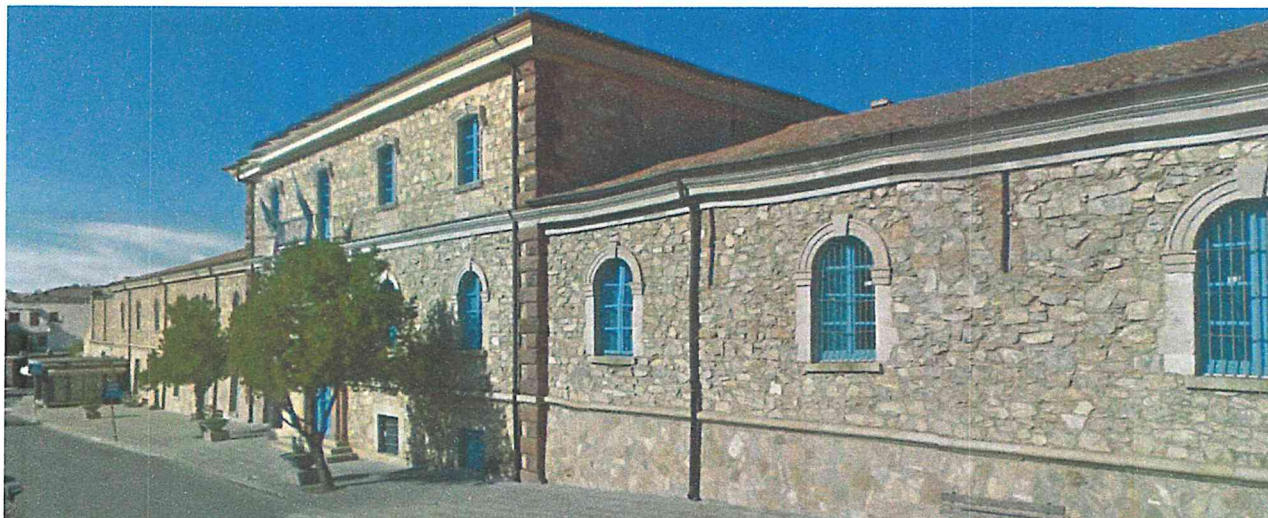
Prospetto principale del fabbricato su via Roma, attuale caserma della Guardia di Finanza
