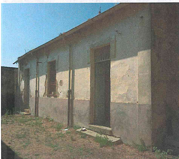
Caseggiati lungo il confine sud-ovest del compendio
