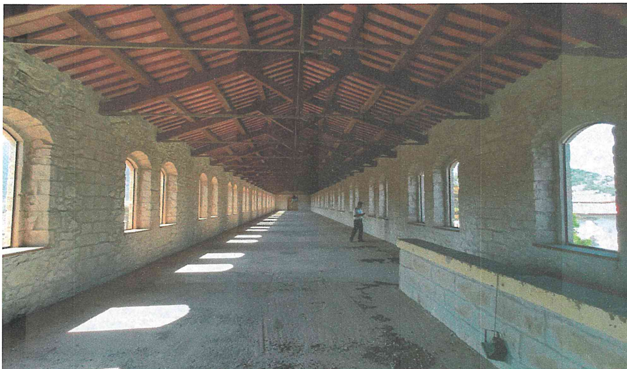
Ambiente al piano superiore del fabbricato di deposito
